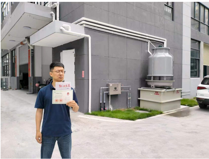
工程师勘察现场相片
